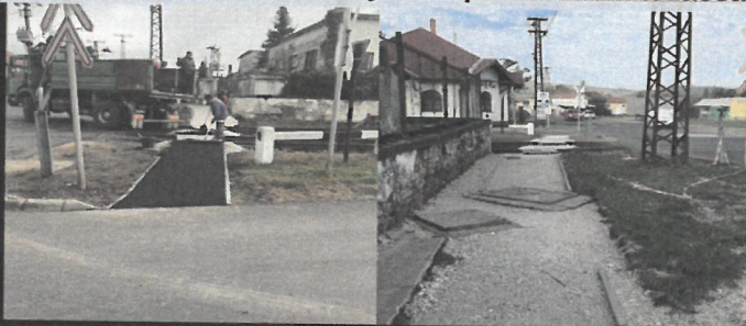
Túrjei úti Vasúti átkelőhöz járda építése aszfalozással
